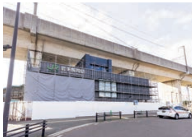
建設が進む、JR岩手飯岡駅の駅舎。
